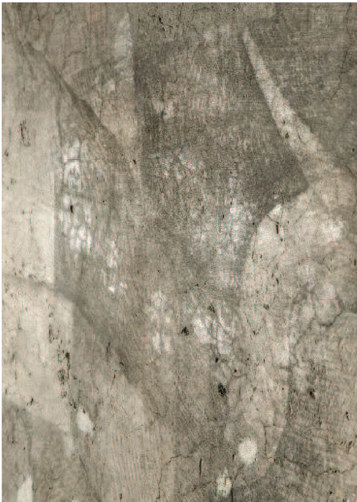
FIG. 12 - Leonardo da Vinci (attr.), Disegno preparatorio della decorazione murale della Sala delle Asse , particolare della parete nord-est a luce radente per evidenziare i riflessi lucidi lasciati dal protettivo steso probabilmente al momento del rinvenimento nel 1895. Milano, Castello Sforzesco, Sala delle Asse
