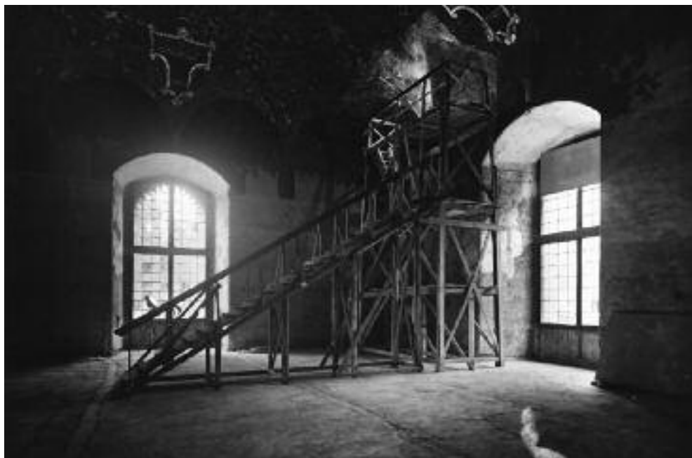
FIG. 6 - Mario Perotti, La Sala delle Asse al Castello Sforzesco durante i lavori di smantellamento dell'allestimento beltramiano: il ponteggio davanti al 'monocromo' leonardesco , stampa alla gelatina bromuro d'argento, 1954, inv. AM 420. Milano, Castello Sforzesco, Civico Archivio Fotografico
