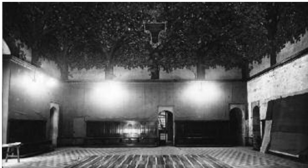
FIG. 4 - Mario Perotti, La Sala delle Asse al Castello Sforzesco durante i lavori di smantellamento dell'allestimento beltramiano, stampa alla gelatina bromuro d'argento, 1954, inv. AM 407. Milano, Castello Sforzesco, Civico Archivio Fotografico
